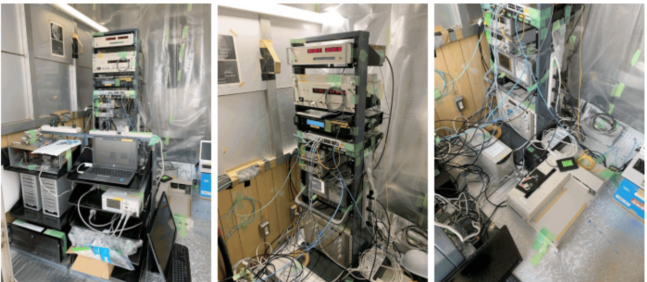
図3 旧赤外小屋に設置した VLBI 観測装置一式.
