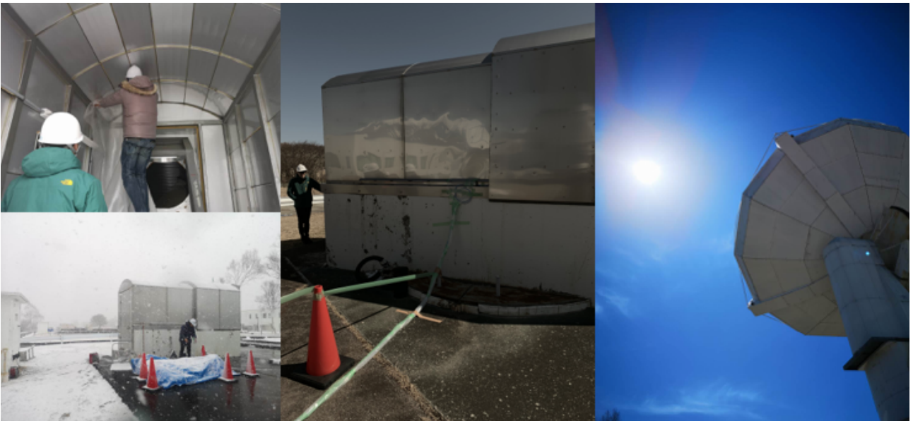
図 14 2019 年 3 月 15-16 日機材設置作業の様子.
