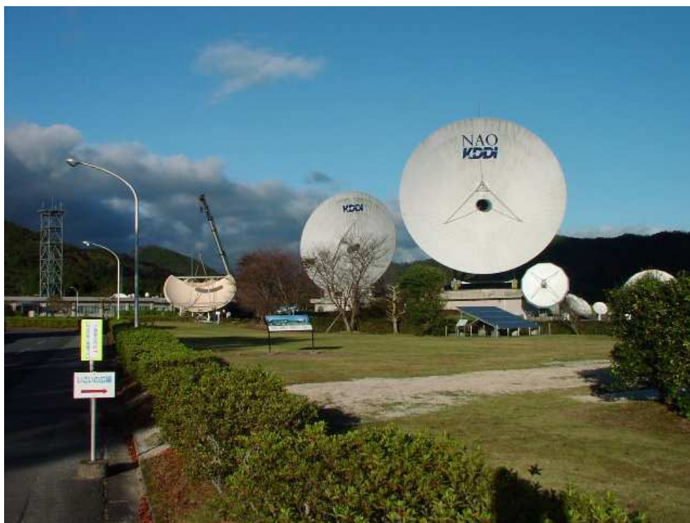
3.2mの隣で建設中のTV受信用アンテナ。 マルチビーム方式のため、独特な形をしている。色も肌色で独特である。
