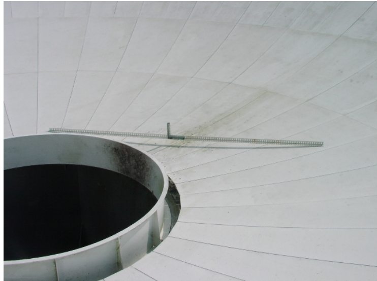
図2. 引き上げ用具（先端の針金は取り付けしていない状態）
