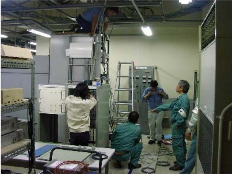
(左) ケーブル敷設作業中：8GHzRFの信号線がやや長くなるが、作業者に干渉しないよう上部の枠に沿わせる形とした。
