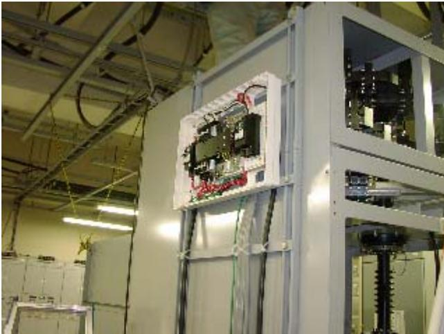
(左) 設置中の天文台分電盤：商用電源100V4系統(2個のラックへ1本ずつ、残りの2本はコンセントにして部屋のなかに配置)、200V単相1系統(コンプレッサ用)
