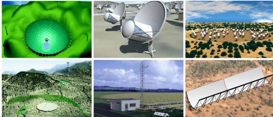
Figure 6.10: SKA で提案されているデザイン。(左上) 中国が提案するアレシポのような巨大な鏡面のデザイン。(左下) カナダが提案する複数のパネルを組み合わせた巨大鏡面と飛行船で空中に配置した副鏡を組み合わせたデザイン。(中上) アメリカが提案する、口径  $12 \text{ m}$  のオフセットパラボラを多数組み合わせたアレイのデザイン。(中下) ヨーロッパが提案する aperture array のデザイン。(右上) オーストラリアが提案する口径  $7 \text{ m}$  の  $64$  台の Luneberg Lenses アンテナを採用したデザイン。(右下) オーストラリアが提案する  $110 \text{ m} \times 15 \text{ m}$  の円筒状鏡面を採用したデザイン。
