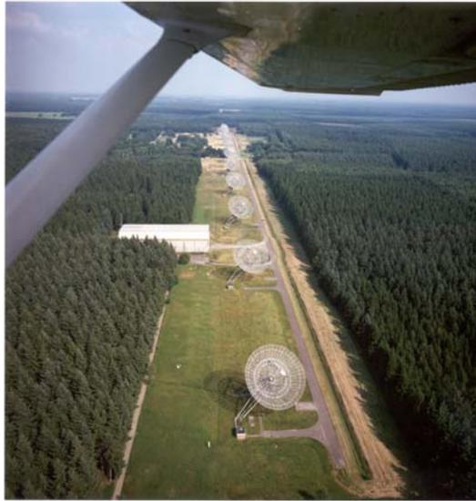
Figure 6.9: オランダのウェスターボーク干渉計。直線状にアンテナが配列されている。
