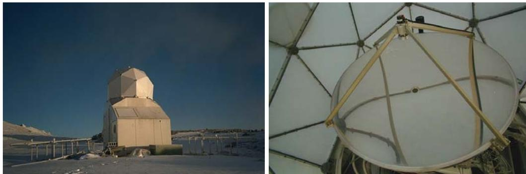
Figure 2.5: 富士山頂に設置された富士山サブミリ波望遠鏡 (口径 1.2m)。サブミリ波では、非常に高い鏡面精度や指向精度が要求される。日射や風雪の影響を除くため、ドーム内にアンテナが設置されている。
