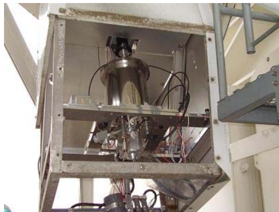
図 4 K 帯受信機室内の冷却増幅部
